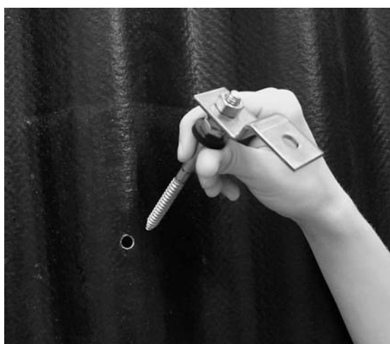
Figure 6 - Fixation pour toiture inclinée, tôle ondulée
