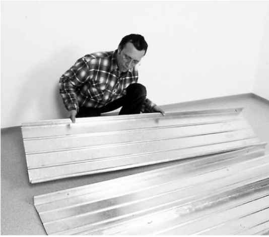
Pose des profils Alu au sol
