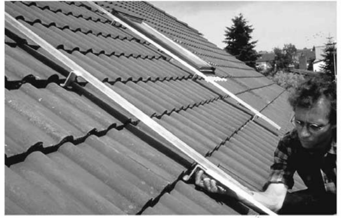
Installation des rails de fixation
