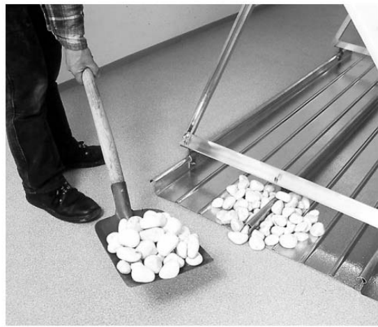
Couverture avec du gravier
